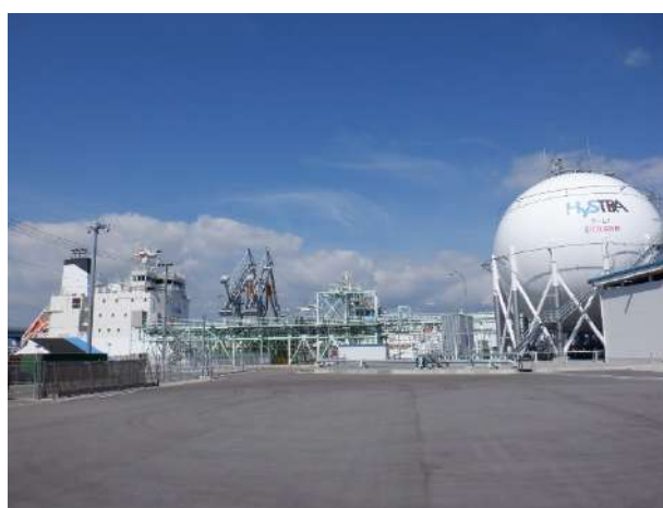
(神戸液化水素荷役実証ターミナル)
